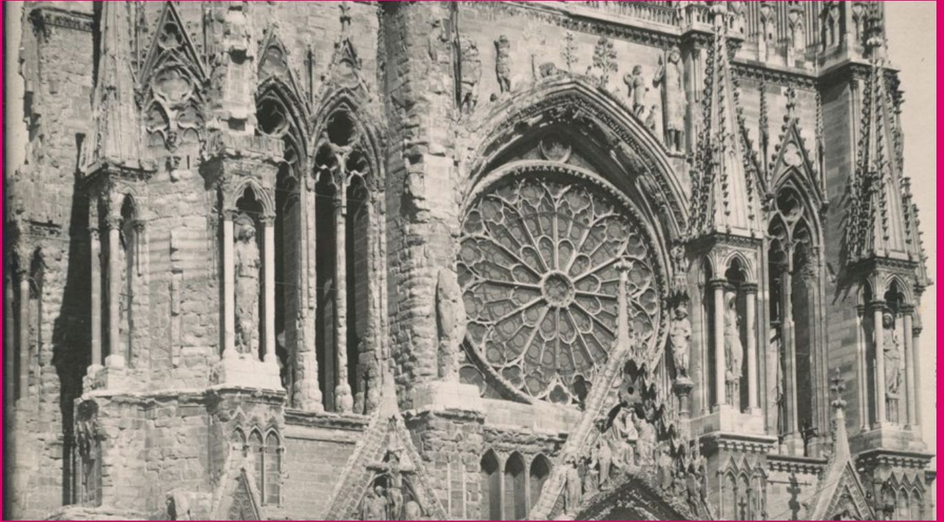
État de l'étage de la grande rose à la fin des années 1920. La partie nord (gauche) léchée par les flammes a perdu la quasi-totalité de son décor. Reims, Bibliothèque Municipale, Duffour, FIC , IX III ia 32
