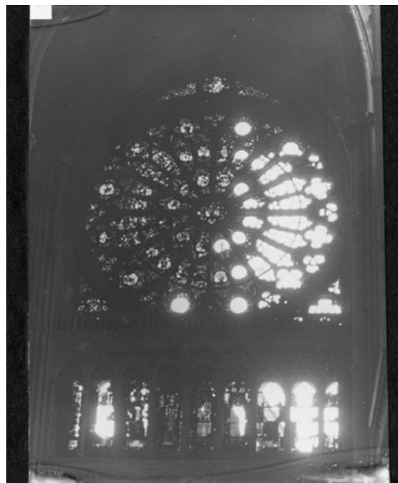
Les vitraux de la partie nord de la rose, soumis directement aux flammes ont quasiment disparu Reims, Bibliothèque Municipale, Collection Sainsaulieu, FI, PDV 14,
