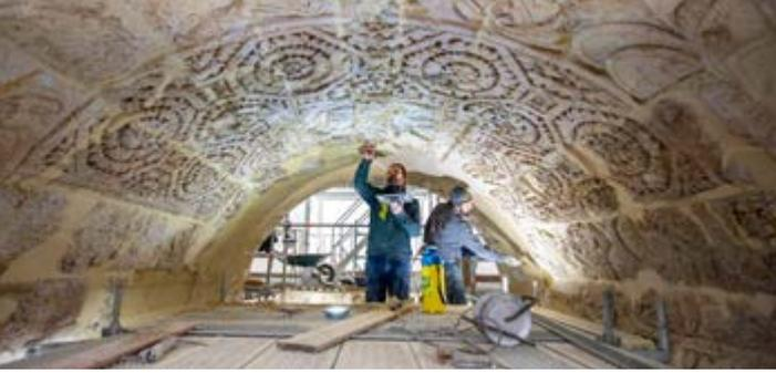
Sur les façades est et ouest, l'ensemble des sculptures font l'objet d'une même restauration en conservation maximale. Les réparations de moellons sont également éteintes pour révéler les maçonneries antiques et restaurées.
